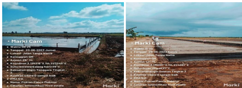
Gambar 48. Pemasangan pagar plastik pada sekeliling lahan lokasi persemaian
