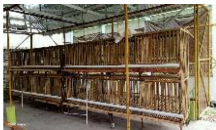
Gambar 35. Renovasi Kandang Perbibitan
