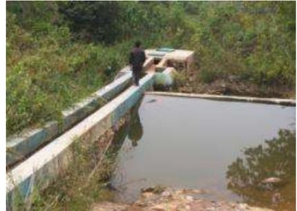
Gambar 7. saluran yang tidak berfungsi diganti dengan sistem pipa dan Lokasi penampung air yang akan disalurkan
